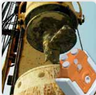
5 - Bušenje temelja Foundation drilling
